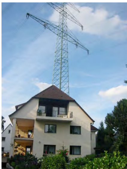
Abbildung 9: Mehrfamilienhaus unter Hochspannungsleitung
